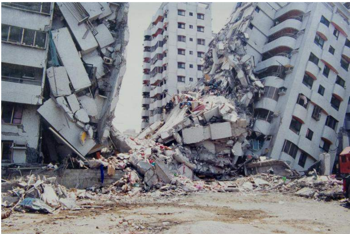
Рисунок 3.25 Будівля з порушенням умов експлуатації
