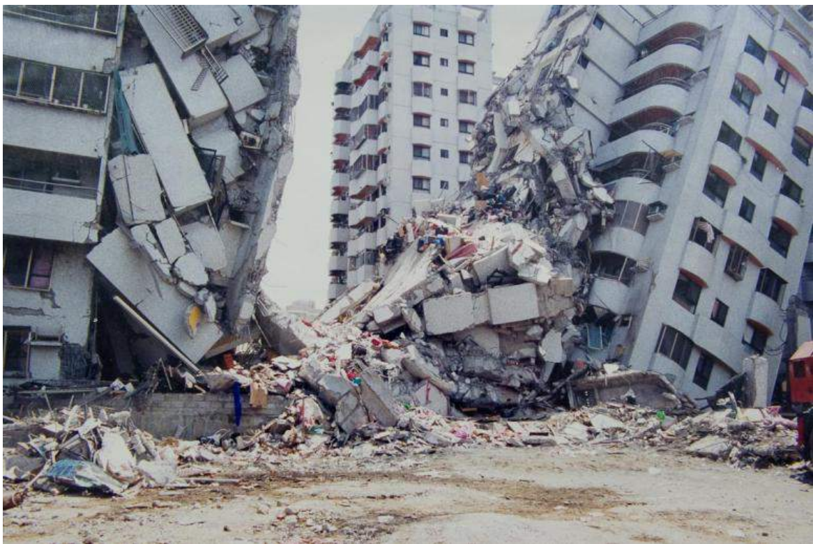
Рисунок 3.25 Будівля з порушенням умов експлуатації
